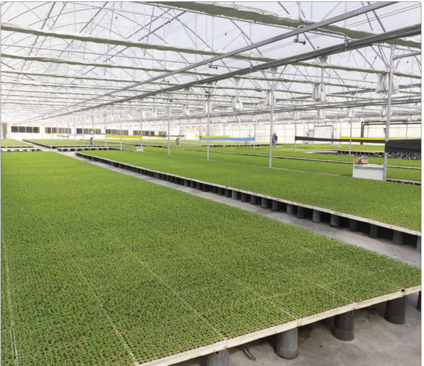
Das fertiggestellte und in Betrieb genommene Gewächshaus im Jahre 2020.
