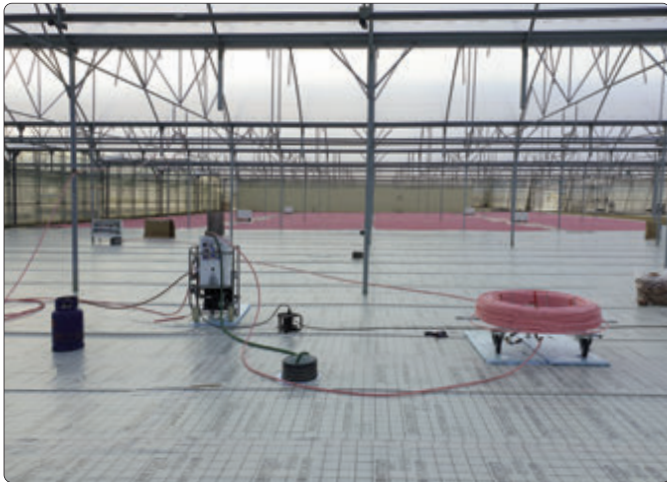
MB-Thermomontage auf der verlegten MB-PE-Folie
