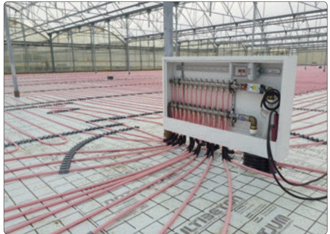
Fertiggestellte Verteilerstation
