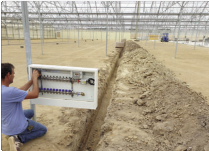
Verteilermontage
