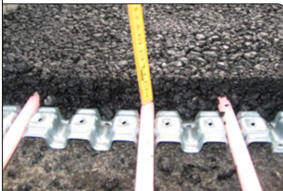
4 cm Asphaltüberdeckung über dem MB-Euro-Systemrohr
