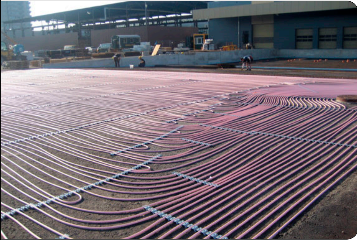
Heizrohre fertig verlegt vor der Asphalteinbringung
