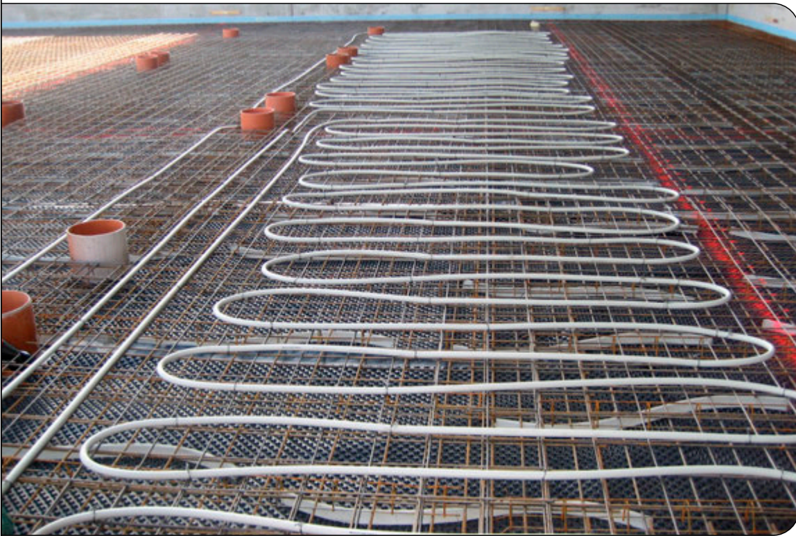
Rampe mit MB-Thermobeton
