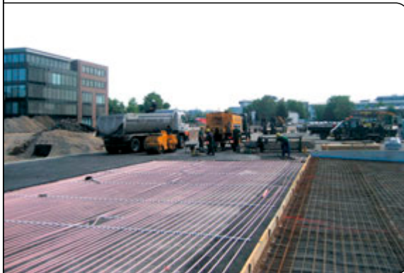
Abstellfläche (links) und Rampe (rechts)
