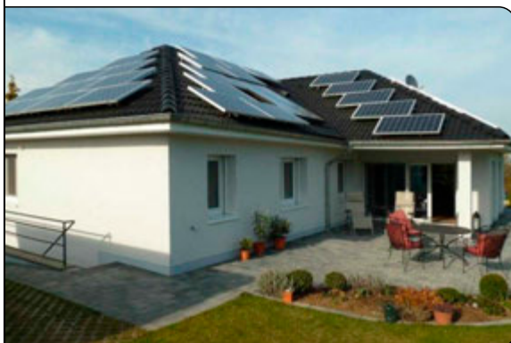
Blick auf Terrasse und Photovoltaikanlage
