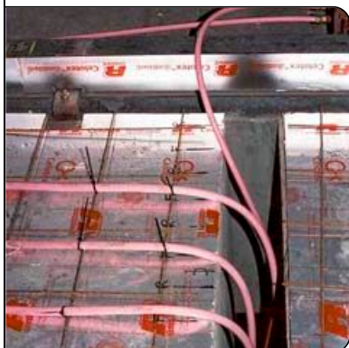
Schacht zum Verteiler
