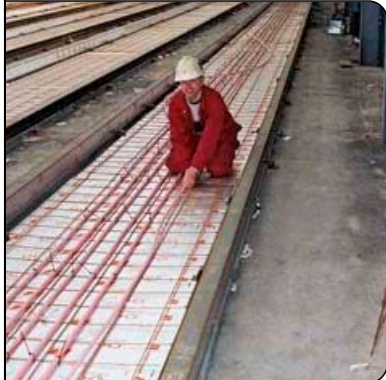
Verlegung der MB-Heizungsrohre
