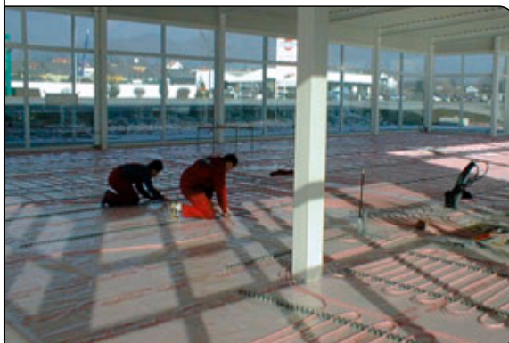
Verlegung der Fußbodenheizung
