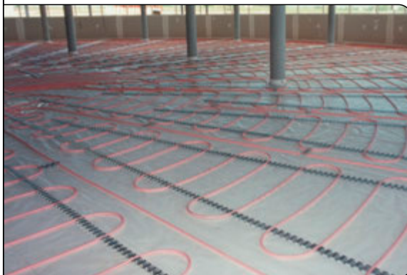
MB-Estrichsystem 17 nach der Verlegung
