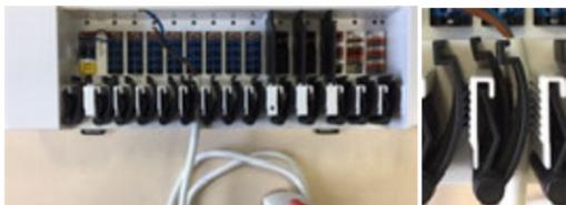
Les serre-câbles conviennent pour les câbles flexibles avec un diamètre de gaine de 5 mm à 8 mm, principalement en utilisant le serre-câbles inférieur (voir illustration).
