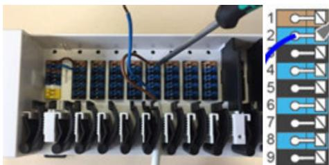
Les câbles massifs ou les fils munis d'embouts spéciaux peuvent être simplement enfilés dans les bornes.
