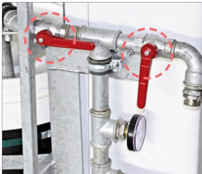
**07. Chauffage du MB-VT (réchauffeur de pose)**
